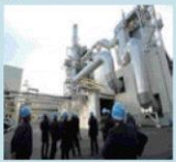
バイオマス発電所
