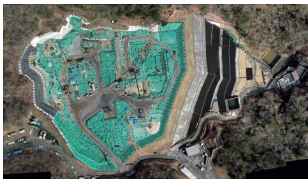
写真3-5-3 特定廃棄物埋立処分施設の様子
