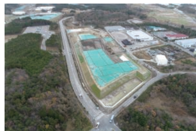
写真3-5-2 土壌貯蔵施設
