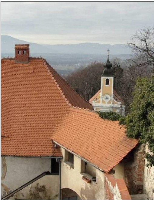
Abb. 21: Der Blick von den Schlossruinen auf die Marienkirche von Wurmberg 628
