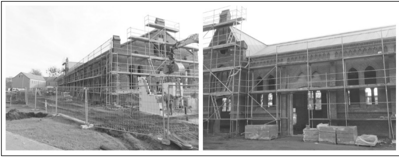
Sanierung der Exerzierhalle, 2013
