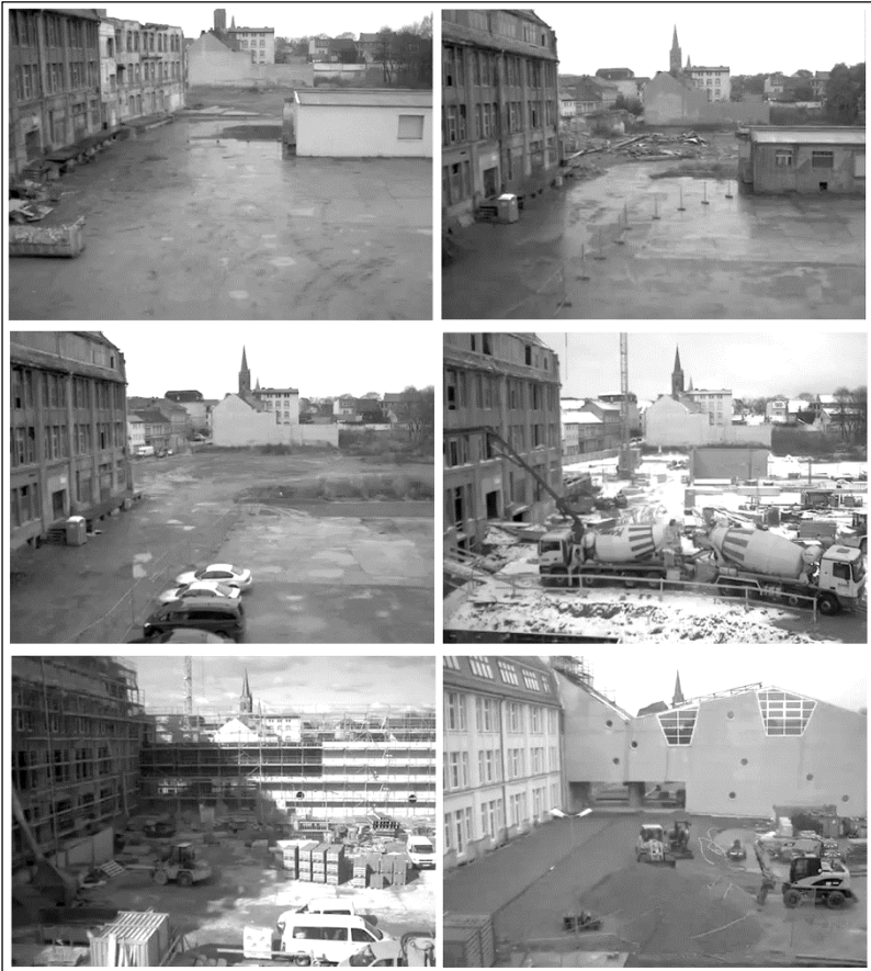
Bildungszentrum Bestehornpark: Bauphasen 2007-2010
