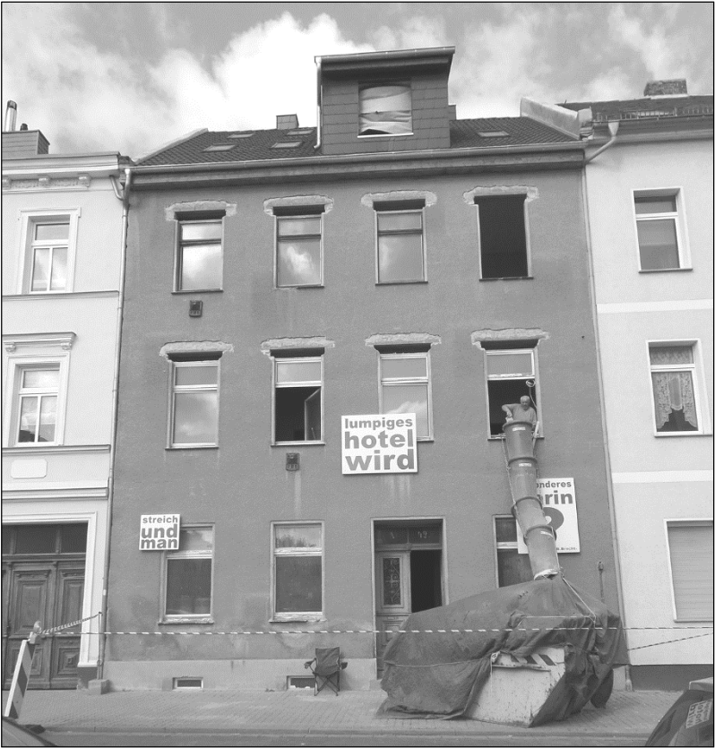
Eines der wenigen noch unsanierten Häuser in der Ludwigstraße im Umbau, 2013
