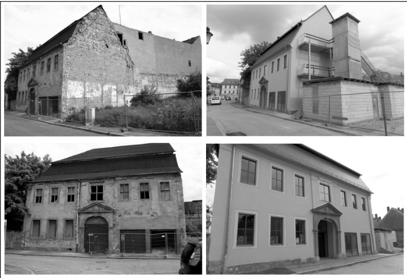
Architektur- und Umwelthaus vor und nach der Sanierung
