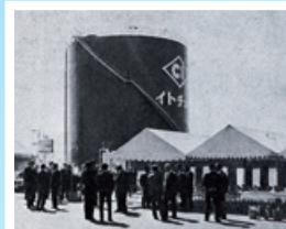
佐世保アスファルト基地が完成、 アスファルト事業に本格参入
