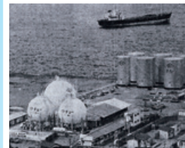
長崎油槽所に LPガス二次基地設備を増設
