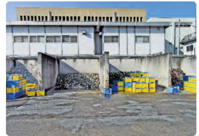
保管施設: スtockヤード
