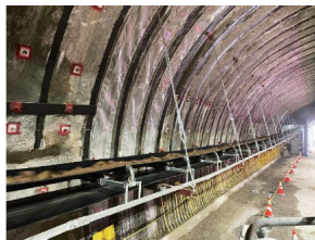
ベルトコンベアによる坑外搬出状況
