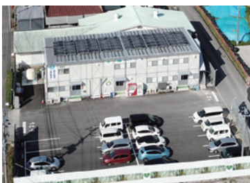
太陽光パネルの設置
