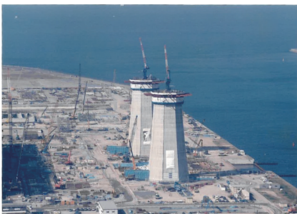
火力発電用 超高煙突をスリップフォーム工法で施工中 スリップフォーム構台の上にJCCクレーンを搭載し一回25mm上昇中
