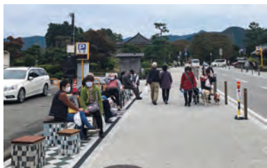
写真10 沿道にベンチ設置 (アフター)
