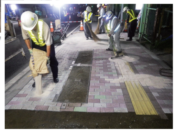
写真：インターロッキングブロックを歩道に設置する工事(青森県八戸市建設部)
