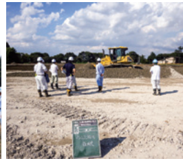
④-2 マシンコントロール
