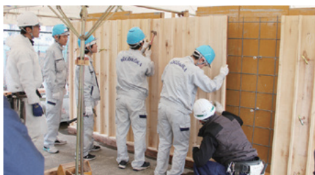
写真3 けんせつ職業体験フェスタでの型枠組立の体験の様子
