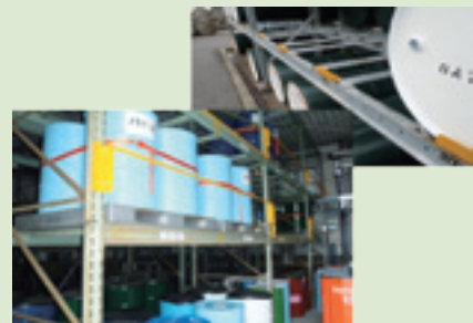
2011年3月7日に設置が完了し、震災による被害を防いだ耐震ラック
