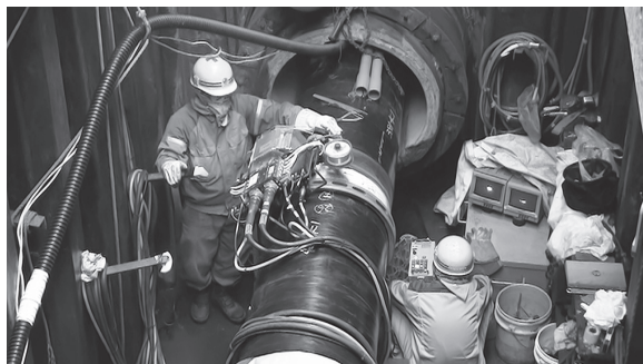
写真5 推進溶接状況
