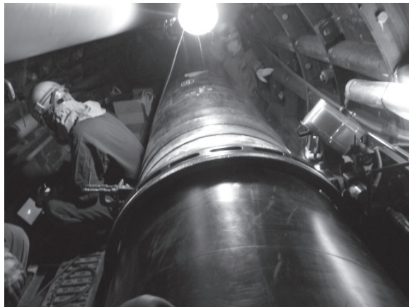
写真4 シールド内溶接状況
