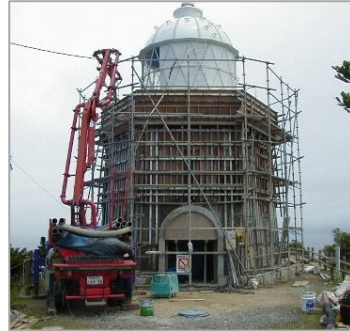
灯台の建設・補修
