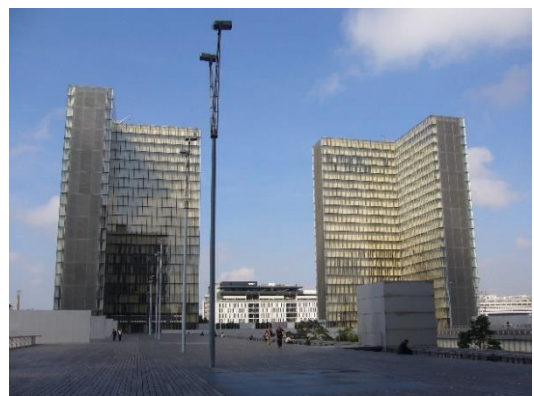
写真2 トルビアック館(2006年)
