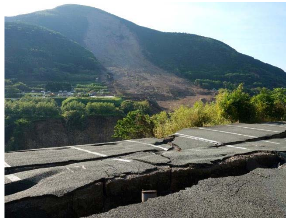
写真2 平成28熊本地震による土砂崩壊
