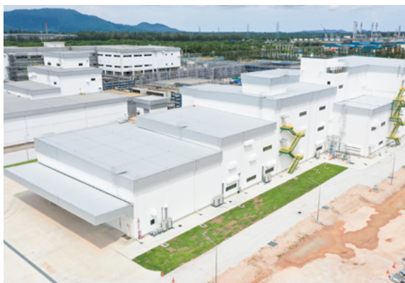
THAI KYOWA ヒトミルクオリゴ糖生産設備 外観
