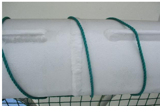
写真5 溶射施工部 (2020年7月)
