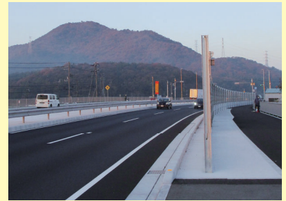
福井交差点付近(供用後) 開通済区間では事故の抑制や歩行者の安全が確保されました
