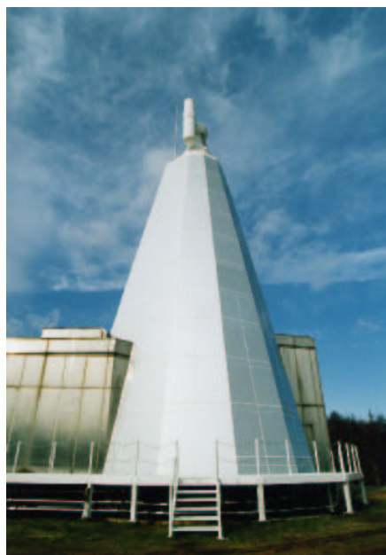
新装なった塔体冷却パネル
