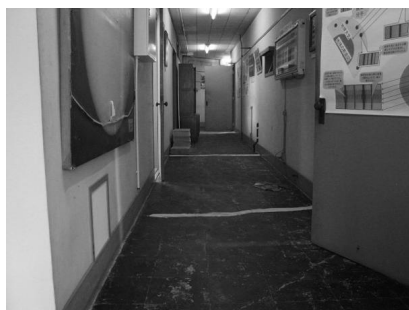
(左) 工事施工中
