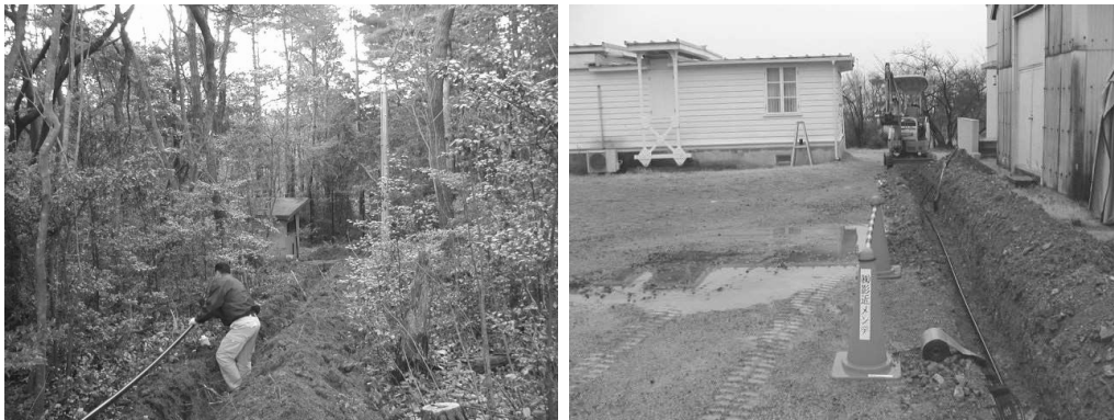
給水管改修工事: 管路掘削、配管状況
