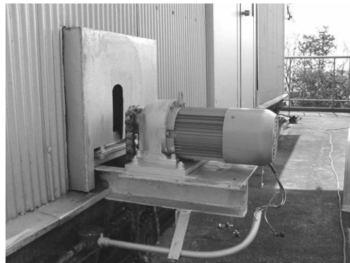
新設モーター取付
