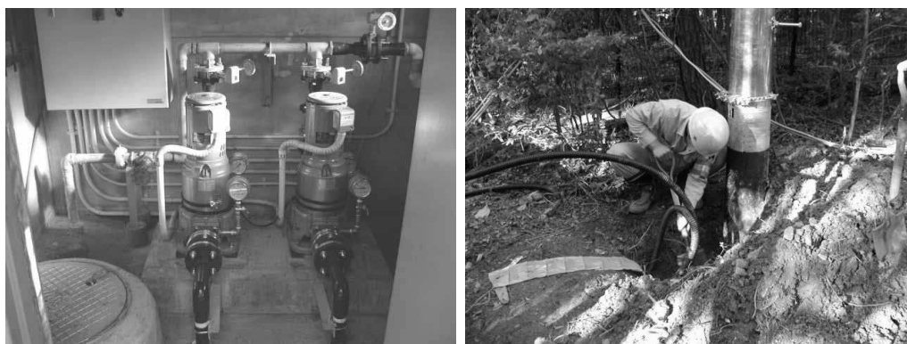
(左) 新設ポンプ取付 (右) 建柱、配線状況
