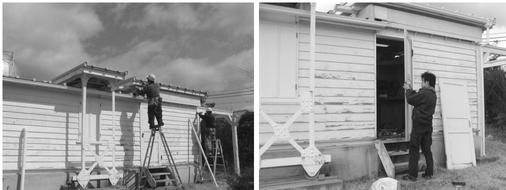
(左) 屋根樋の設置 (右) 入口扉の取替
