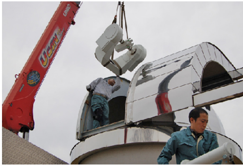
写真 1：飛騨天文台での FMT 解体作業
