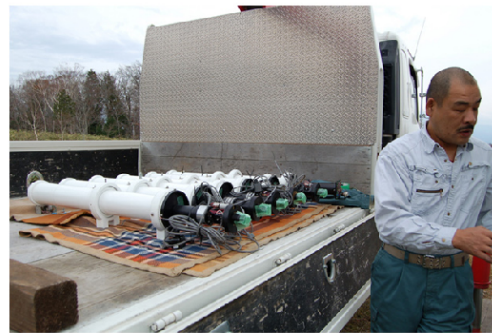
写真 2：飛騨天文台での FMT 解体作業
