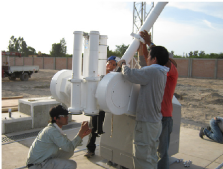
写真 3：ペルーでの FMT 組立作業
