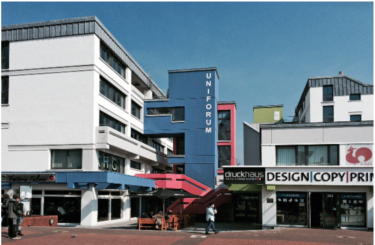
12 Farbgestaltung der Treppentürme. 2013.
