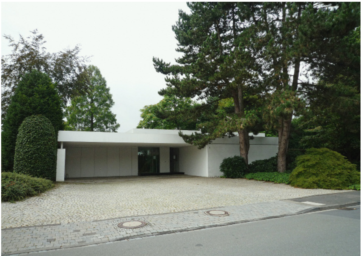
8 Rheda-Wiedenbrück, Rektoratsstraße 3, Unternehmervilla (Straßenseite), erbaut 1968. Architekt Joachim Hanke, Bielefeld. 2015.
