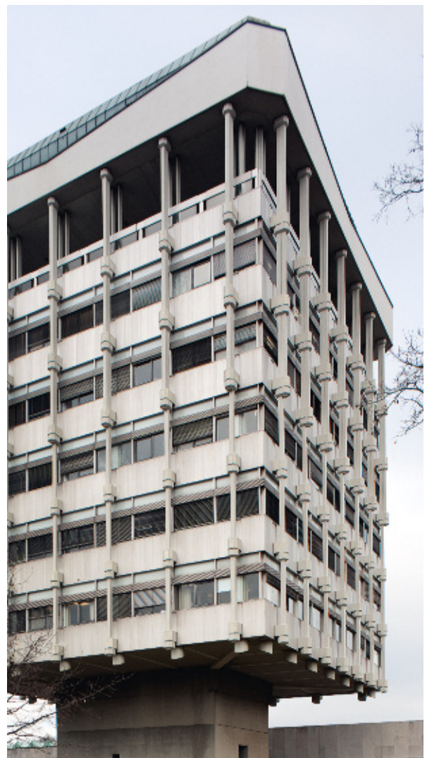
Marl, Rathaus; der südliche Dezernatsturm von Südwesten. 2011.
