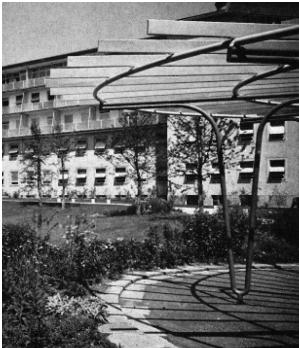
5 Pergolenkonstruktion aus Stahlrohr und Holz. Mitte der 1950er-Jahre.
