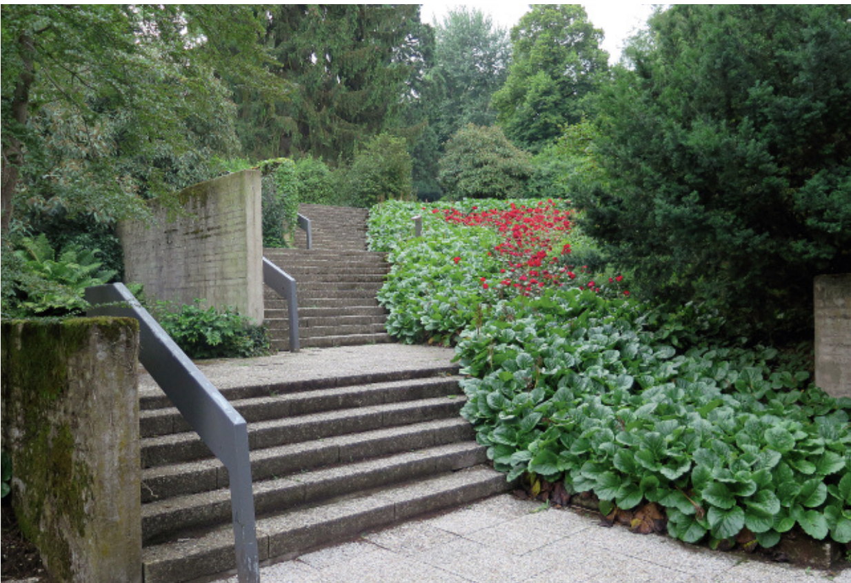
13 Aktueller Zustand der Treppenanlage im Rosengarten. 2015.
