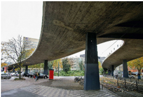
14 Düsseldorf, Untersicht des Tausendfüßlers. 2006.
