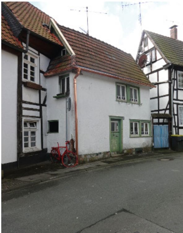
3 Iserlohn, Südengraben 28. Ansicht des Mauerhauses von Nordosten. 2016.
