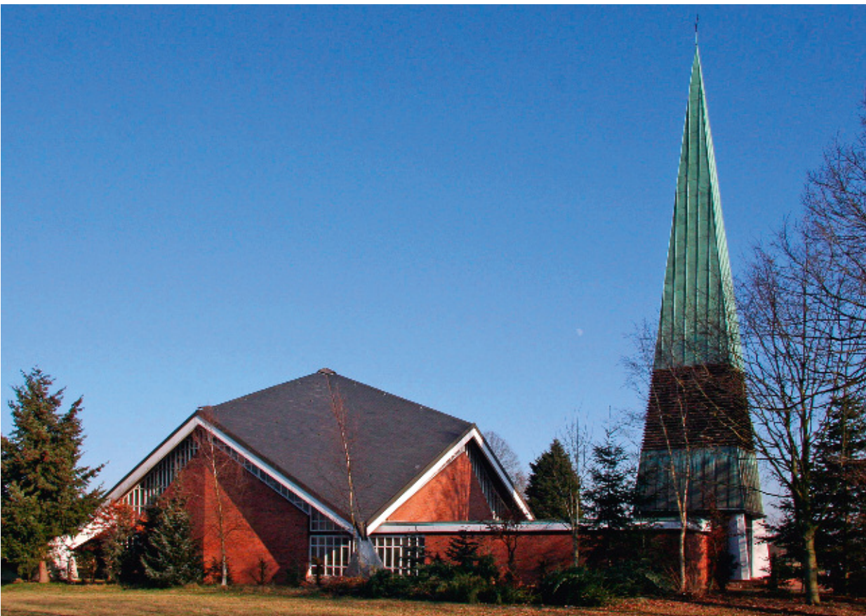
15 Telgte, St. Christophorus (katholische Kraftfahrerkapelle), erbaut 1964. Architekt Eberhard M. Kleffner. 2012.
