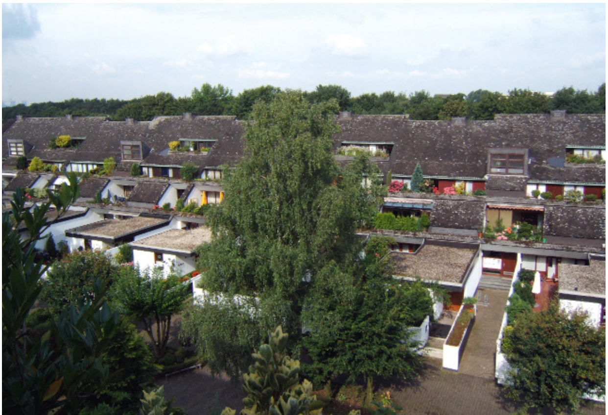
5 Marl, „Hügelhaus“, erbaut 1965–1967. Architekten Roland Frey, Hermann Schröder, Claus Schmidt, Stuttgart. 2007.
