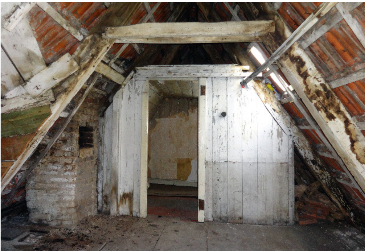
9 Iserlohn, Südengraben 28. Erhaltene Teile der historischen Innenausstattung, vermutlich Mitte des 19. Jahrhunderts entstanden: die in den Dachboden eingebaute Kammer vor dem westlichen Seitengiebel. 2016.
