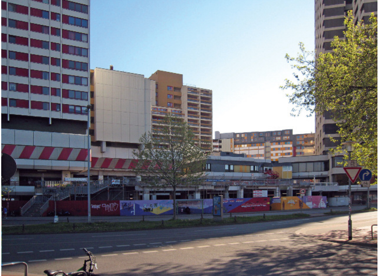
1 Hannover, Ihme-Zentrum, errichtet 1971–1975. 2016.
