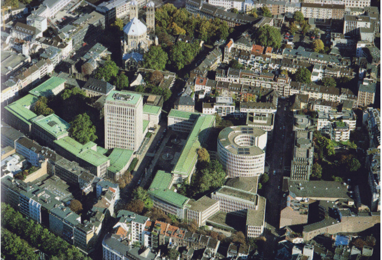
7 Köln, Blick auf die Bauten des Gerling-Konzerns mit St. Gereon (oben) und Ringstraße (unten). 2004.
