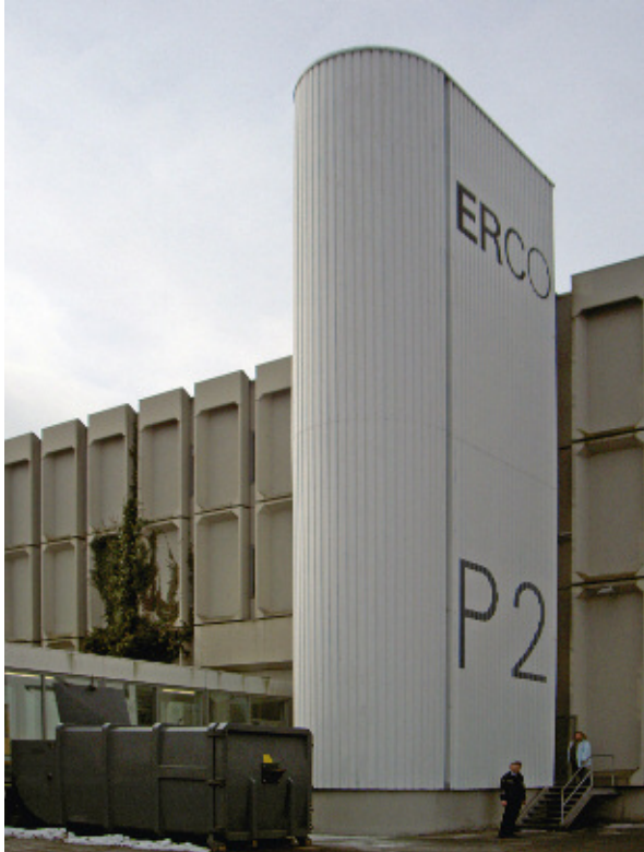
3 Erco Produktionshalle P2 in Lüdenscheid. 2006.
