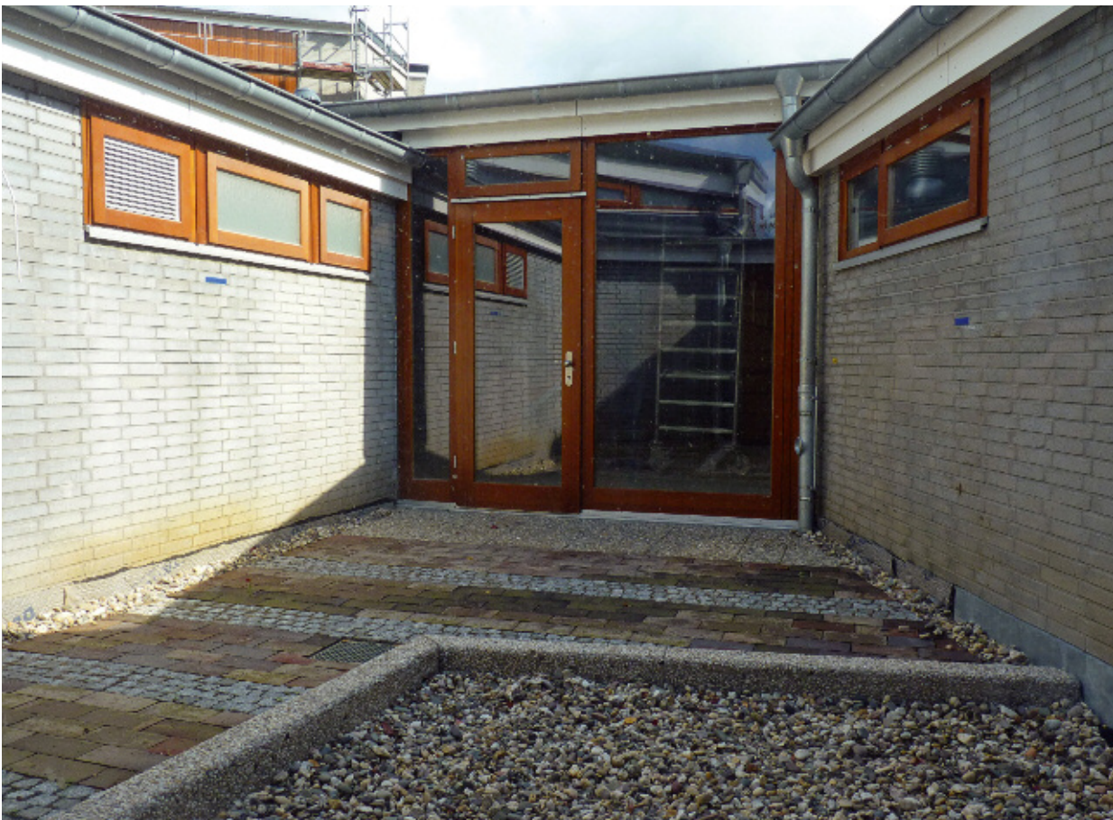
14 Innenhof nach der Sanierung. 2016.
