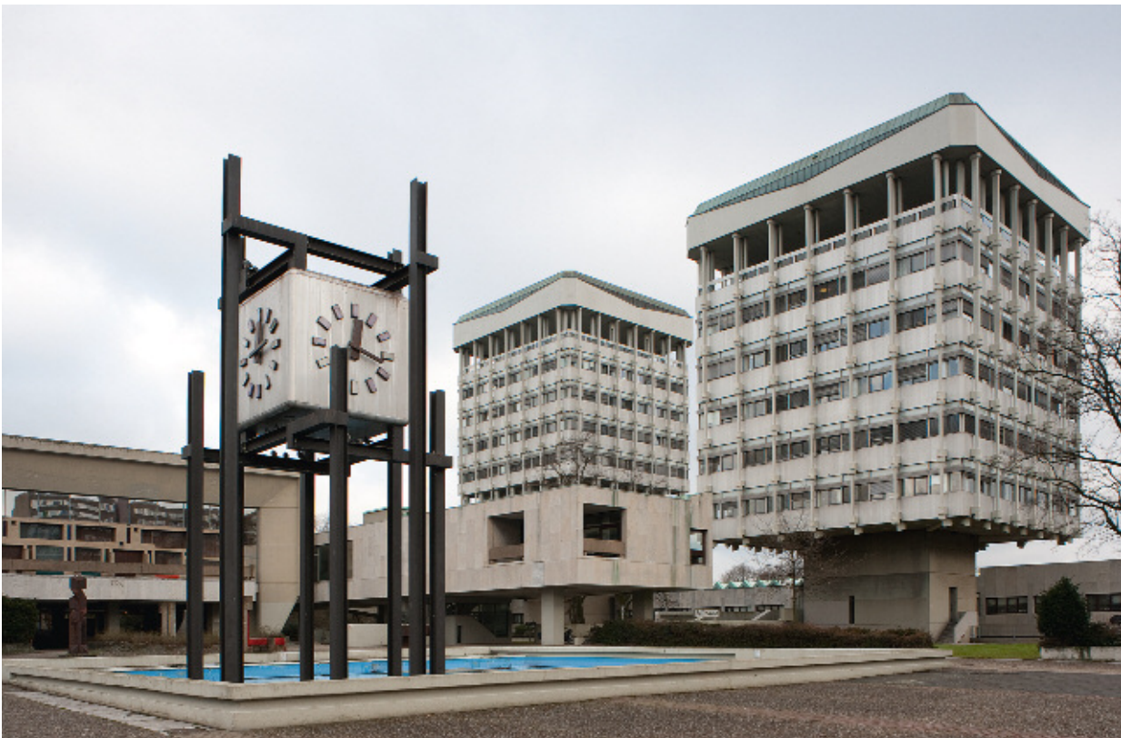
5 Marl, Rathauskomplex, erbaut 1960–1969. Architekten Johan Hendrik van den Broek, Jacob Berend Bakema. 2016.
