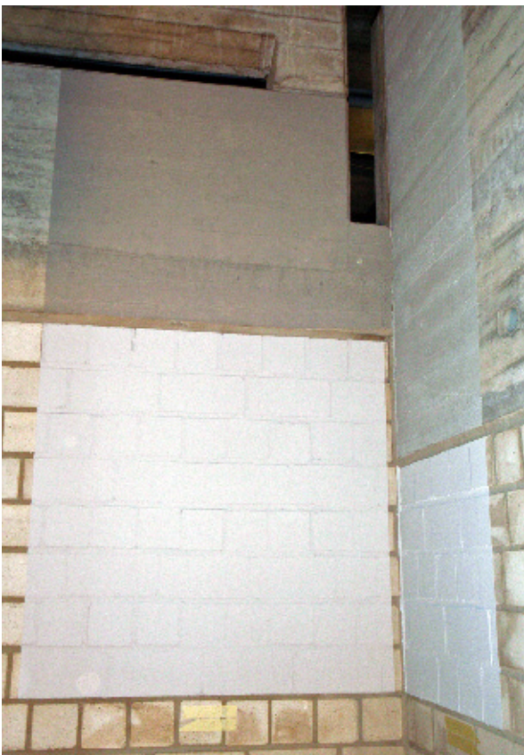
10 Betonlasuren auf Probeflächen. 2013.
