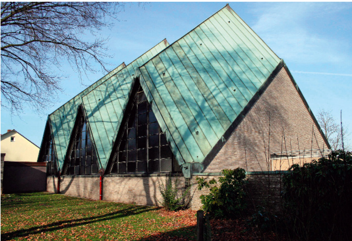
4 Lippstadt, Johanneskirche (evangelisch), erbaut 1962/63. Architekt Rainer Mumme. 2014.
