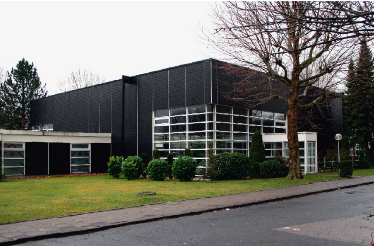
18 Oer-Erkenschwick, Gemeindezentrum St. Josef (katholisch), erbaut 1970–1972. Architekten Joachim und Margot Schürmann. 2011.
