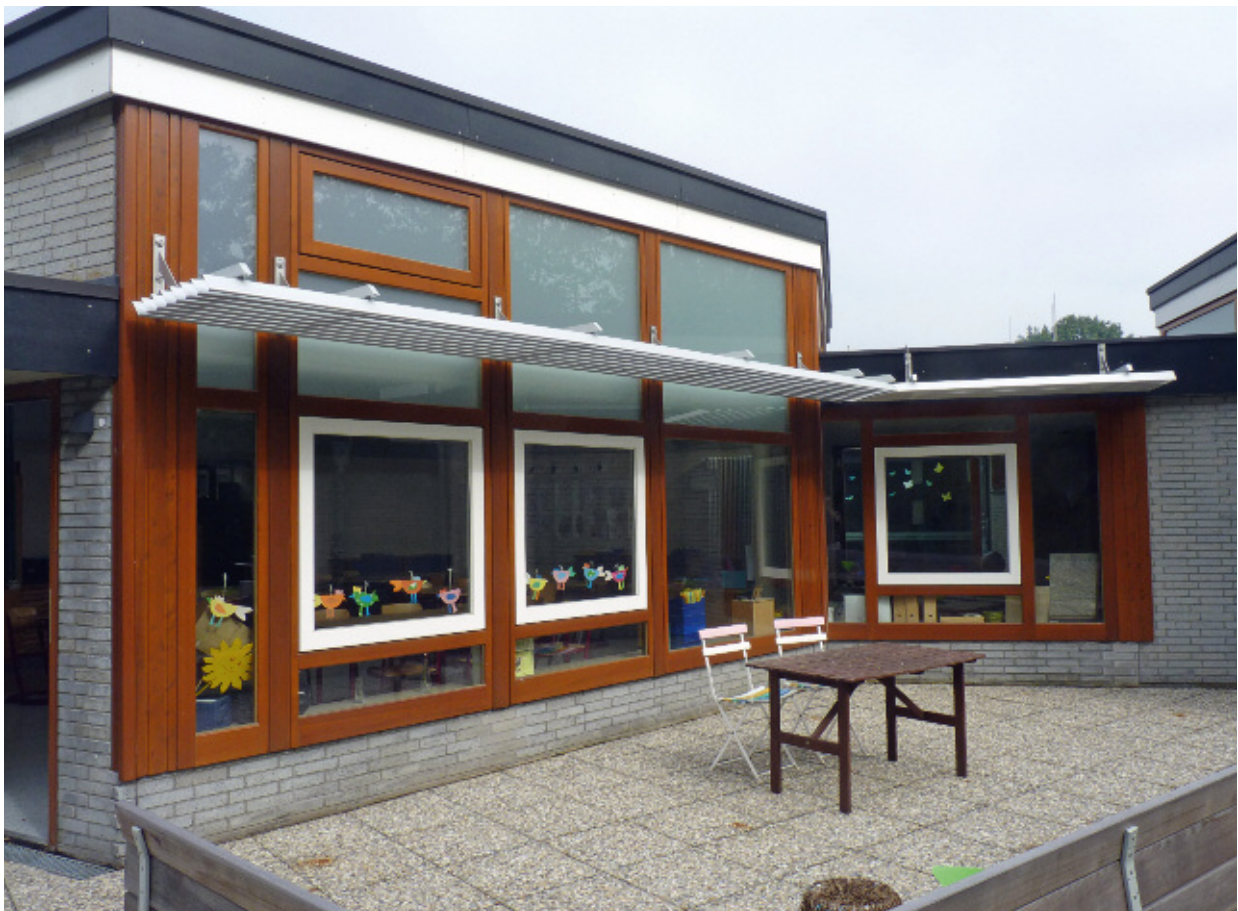
13 Unterstufenklasse nach der Sanierung. 2015.
