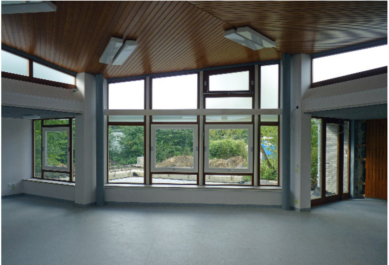
15 Unterstufenklasse nach der Sanierung. 2013.
