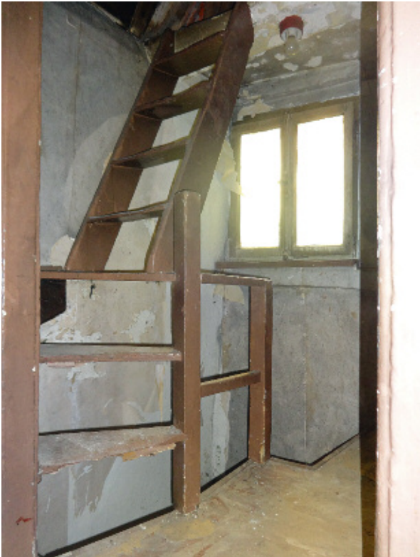
8 Iserlohn, Südengraben 28. Erhaltene Teile der historischen Innenausstattung, vermutlich Mitte des 19. Jahrhunderts entstanden: Leiter-Treppe zum Dachboden. 2016.
