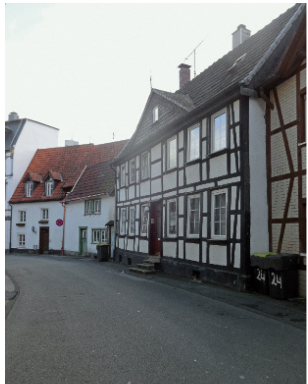
12 Iserlohn, Südengraben 28. Blick von Westen. 2016.
