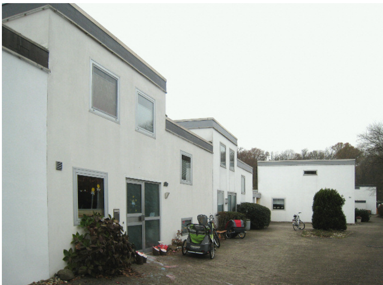
6 Münster, Siedlung Schlesienstraße, erbaut 1963–1964. Architekten Max Clemens von Hausen, Ortwin Rave, Münster. 2011.
