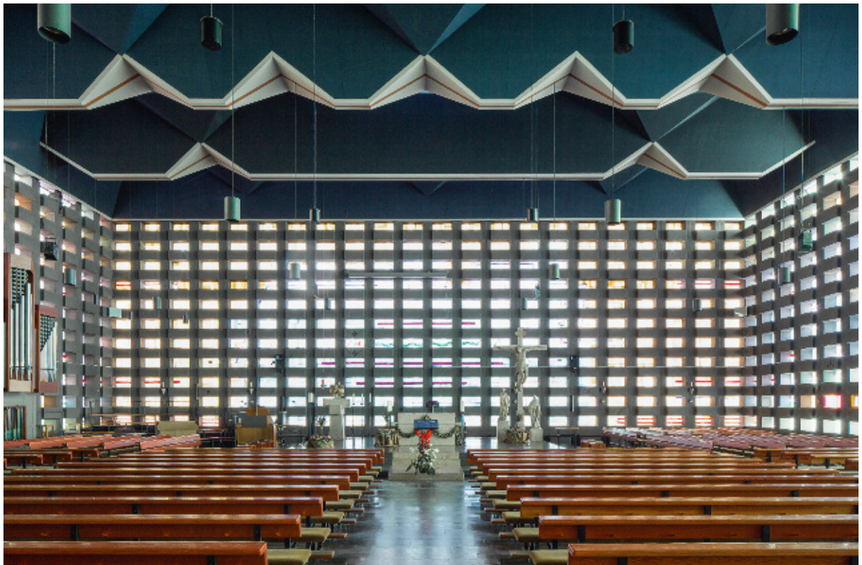
13 Ahaus, St. Mariä Himmelfahrt, Innenraum. 2012.
