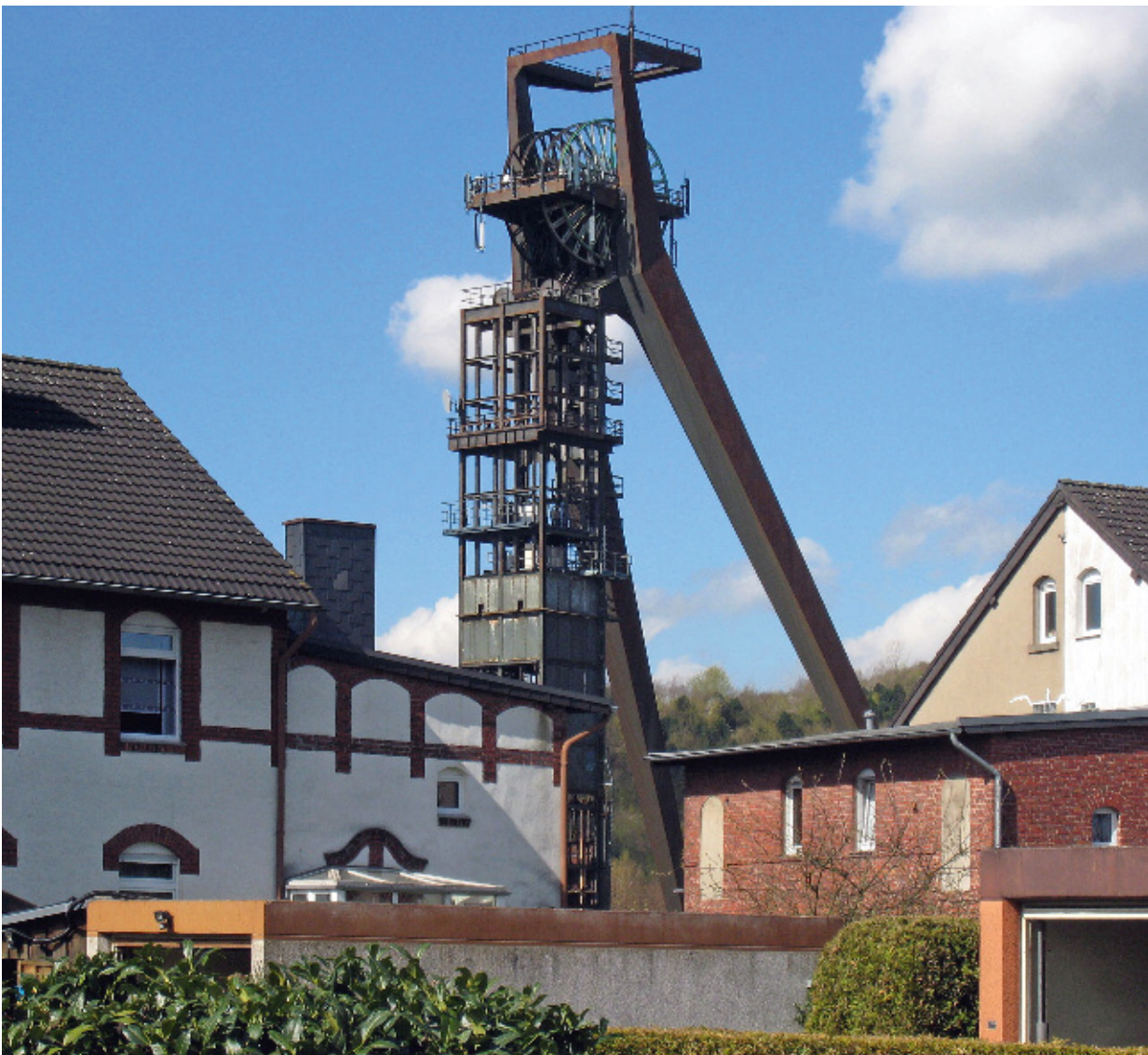
9 Fördergerüst von Schacht „Konrad Ende“, Zeche Recklinghausen II in Recklinghausen-Hochlarmark. 2016.
