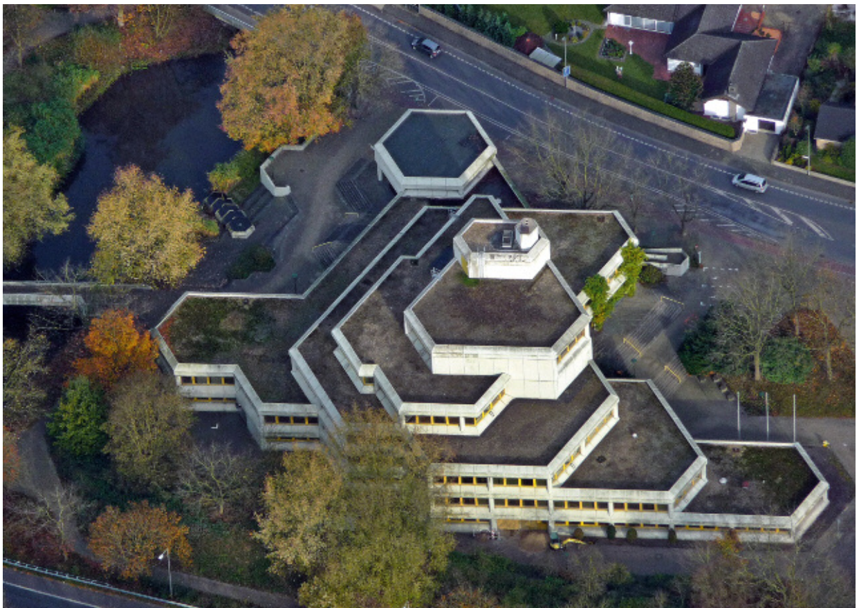
4 Gronau, Rathaus, erbaut 1973–1976. Architekt Harald Deilmann. 2014.
