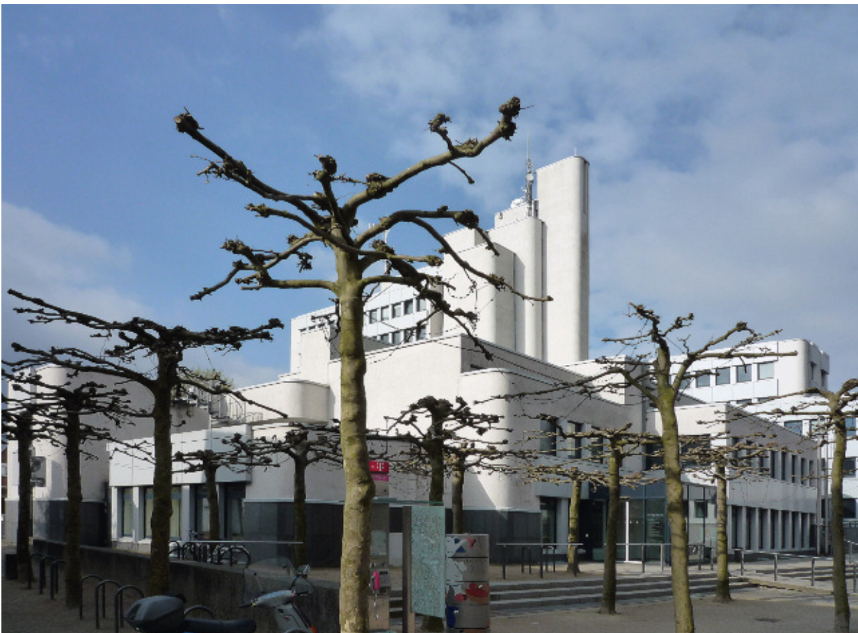
8 Rheda-Wiedenbrück, Rathaus, erbaut 1972–1974. Architekt Harald Deilmann. Zustand nach der Fassadensanierung 2016.
