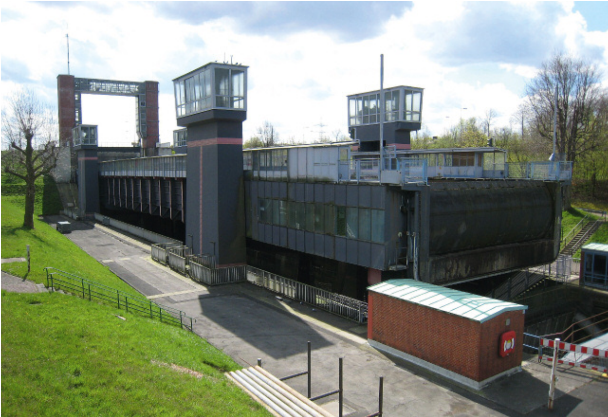
5 Neues Schiffshebewerk Waltrop. 2016.
