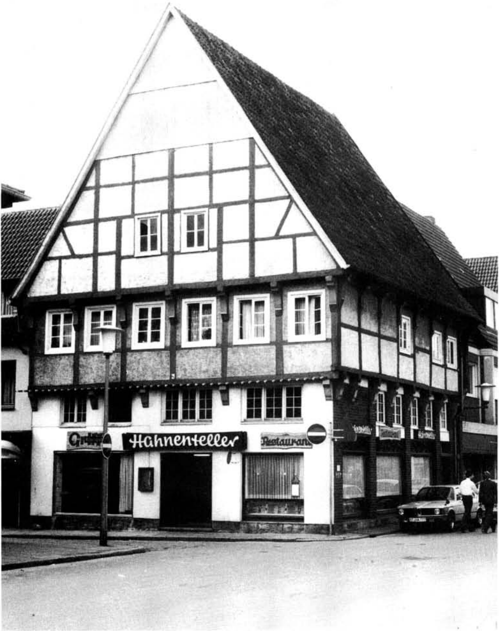
Abbildung 27 Rheda-Wiedenbrück, — Wiedenbrück, In der Halle 4 von 1513 (d)
