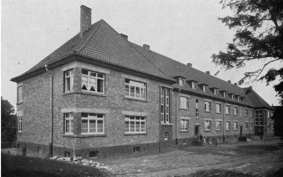
Abb. 13: Franz Mündelein, Wohnhaus für Postbeamte an der Schulbreite. Foto: Walter Müller (Repro aus: Paul Michels: Paderborn – Bad Lippspringe. Berlin 1931, S. 48)
