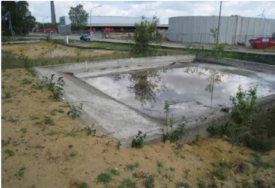
Abb. 4: Betonwanne auf dem Gelände der Freiherr-vom-Stein-Kaserne. Linksseitig ist die nachträglich eingebrachte flache Betonrampung gut zu erkennen. (Foto: Olaf Miosga)
