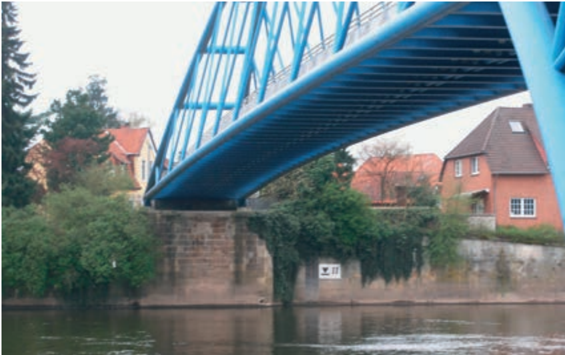
Abb. 21: Wesertorbrücke in Nienburg (Widerlager von 1714; Metallbrücke von 2000)
