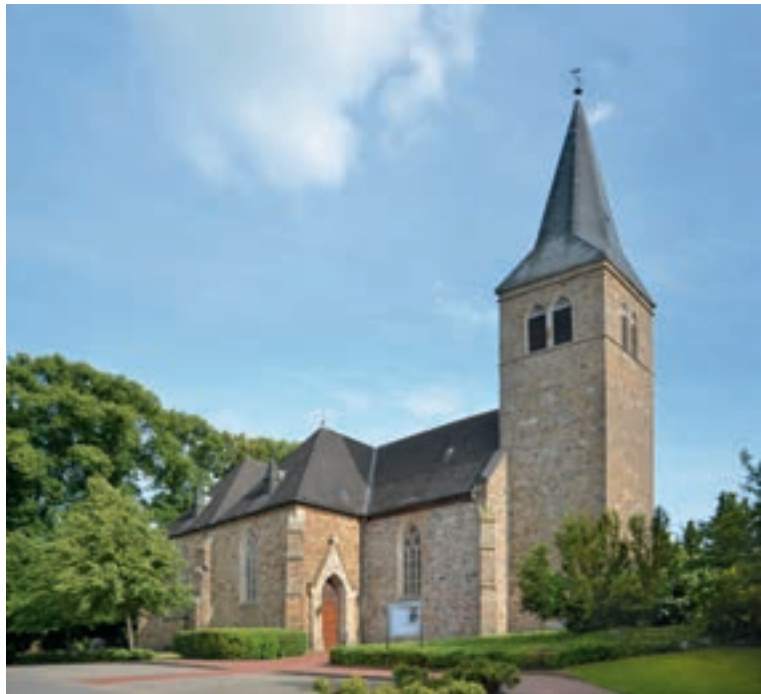
Abb. 35: Berge: St. Servatius 1180 Turm- und Kirchenschiffbasis: Findlinge, darüber MK IId-Sandstein.
