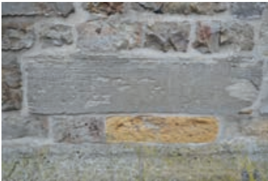
Abb. 38a: Im Turmbereich häufig MK I-Sandsteine (Feinschichtung)
