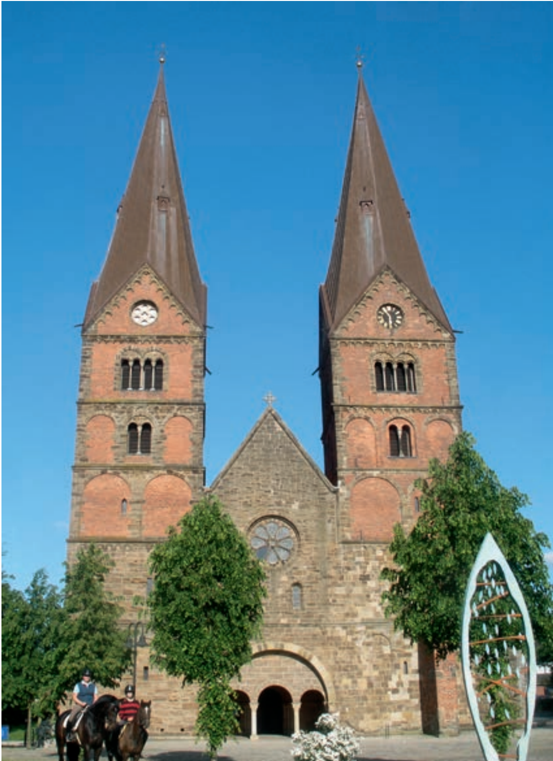
Abb. 56: Stiftskirche in Bücken; Nordseite der Kirche mit romanischer Fassade, die mehrere Rundbogenfriese aufweist; 1863-1868 Sanierung der fast baufällig gewordenen Kirche, Steinersatz mit hellem Sandsteinmaterial (vermutlich Obernkirchener Sandstein)
