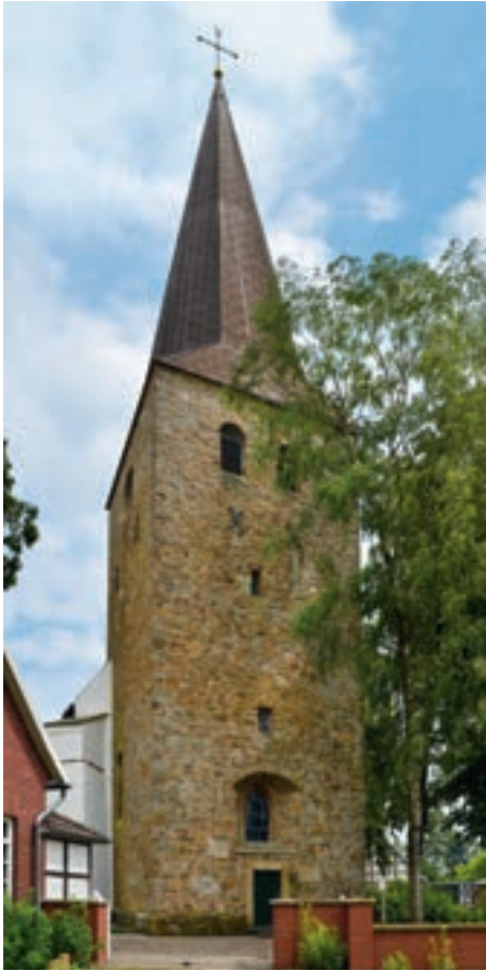
Abb. 46: Menslage: St. Marien (1247), Turm: 1579; Kirchenschiff: 1949 (verputzt) Turm mit einzelnen Findlingen. Das aus Raseneisenstein erbaute Kirchenschiff wird am 10.04.1945 von einem Artilleriegeschoss getroffen, brennt vollständig aus und stürzt am 11.01.1946 ein. Auch der Turm brennt aus, bleibt aber erhalten.
