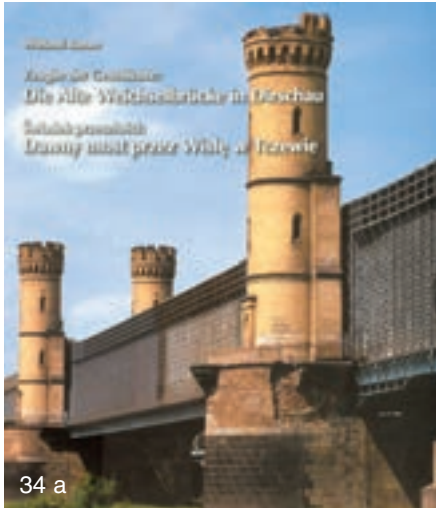
Abb. 34 a: Weichselbrücke bei Dirschau, Titelblatt des Buches von W. RAMM, in dem der Porta-Sandstein Erwähnung findet („zur Verstärkung der Sockel und Kanten (der Pfeilertürme) wurden je nach der Höhe der zu erwartenden Beanspruchung Quader aus Sandstein, Basalt oder Granit verwendet... Der Sandstein stammte aus einem Steinbruch an der Porta Westfalica und aus der Gegend von Minden“ (RAMM 2004: 65).
