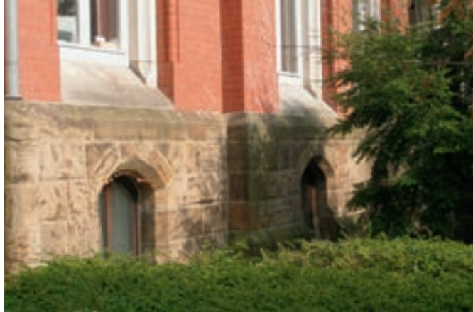
Abb. 26: a und b: Villa des Zigarrenfabrikanten Leonarda von 1879 in Minden, Marienstraße 32. Der Sockel besteht aus fünf bis acht Reihen großer Sandsteinquader, die ursprünglich als Bausteine für die Mindener Festung verwendet worden waren (FABER-HERMANN 2000: 99)
