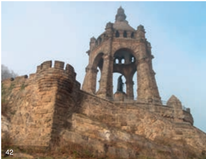
Abb. 42: Südseite des Kaiser-Wilhelm-Denkmals: Heersumerschichten (unterer Malm), Quadersteinmauerwerk und z. T. Bruchsteinmauerwerk
