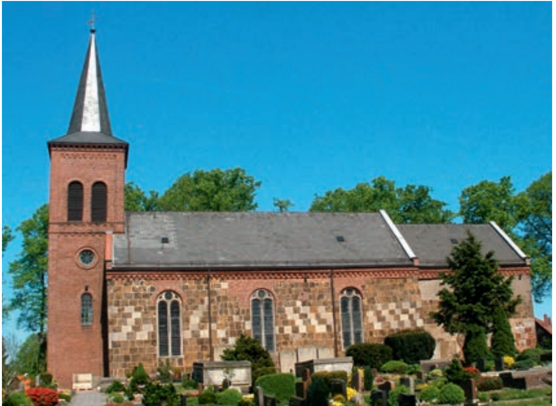
Abb. 55: Ev. Kirche St. Laurentius in Abbehausen (1862); Porta-Sandsteinquader der alten Kirche von 1280 sind möglicherweise wiederverwendet worden. Steinersatzmaterial: Schilfsandstein (Keuper)
