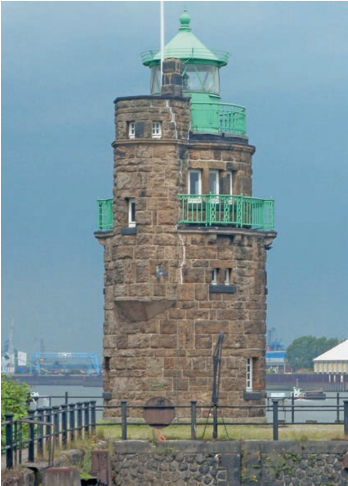
Abb. 41: Mäuseturm im Überseehafen von Bremen; diente als Leuchtturm für die ein- und ausfahrenden Schiffe; 1906 erbaut, nach teilweiser Zerstörung durch einen Schiffsunfall 1926 mit den alten Sandsteinquadern neu errichtet
