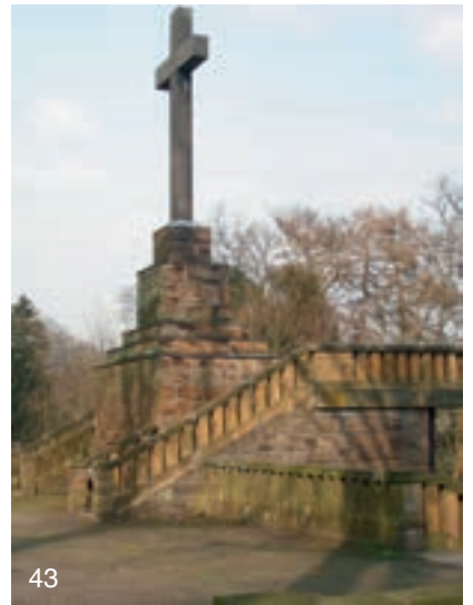
Abb. 42: Südseite des Kaiser-Wilhelm-Denkmals: Heersumerschichten (unterer Malm), Quadersteinmauerwerk und z. T. Bruchsteinmauerwerk
