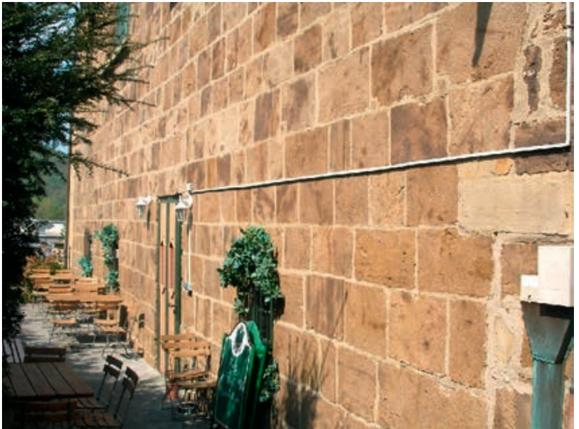
Abb. 28: Torhaus der Schalksburg (Südseite) mit großen Quadern aus Porta-Sandstein, heute Gaststätte („Burgschänke“)
