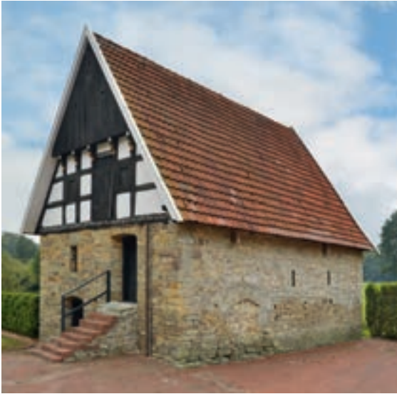
Abb. 68: Ankum-Westerholte: Grote 1751 Der Speicherbau weicht vom Bautyp der anderen Steinwerke ab. 1751: Inschriftstein im Mauerwerk und Spruchband im Fachwerkgiebel. (s. Prinzhorn, 2008: 265, Fußnote)
