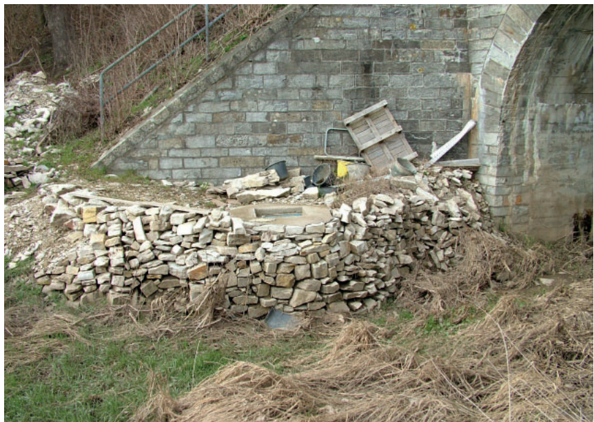
Abb. 10: Gesicherter und ausgebauter Bakenponor im Haxter Grund auf der Westseite der Brücke der alten Warburger Straße über den überwiegend trocken liegenden Ellerbach (März 2021).
