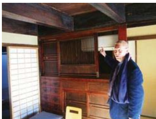
エアコンは格子戸に入れて隠す
