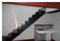
洗面台の増設
