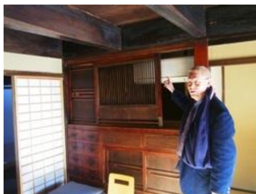
エアコンは格子戸に入れて隠す
