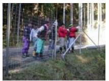
侵入防止柵の設置
