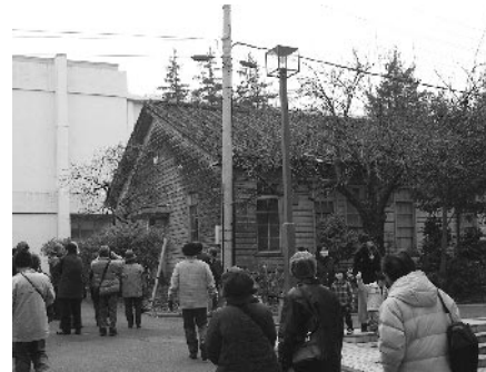
五号棟解体前見学会
