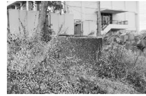
新たに確認された「防火水槽」
