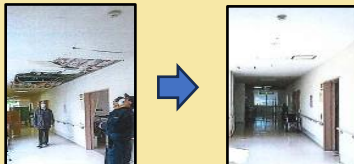
【介護施設の復旧の様子】
