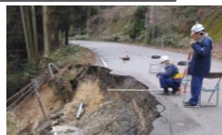
危険箇所での被災状況調査
