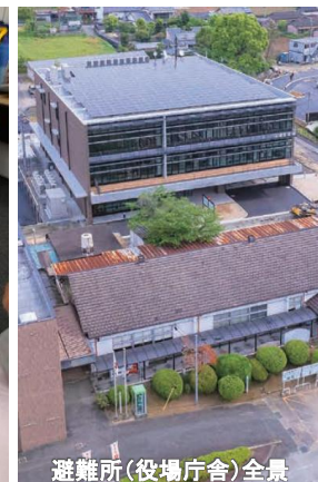
避難所（役場庁舎）全景
