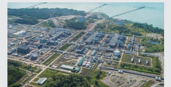
液化プラント既存第2系列および建設工事の拡張系列、LNGタンク、棧橋等
