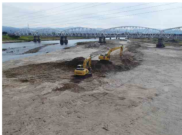
写真1 河川内に堆積した土砂の掘削工事
