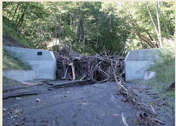
流木捕捉式治山ダムの設置時及び豪雨後の様子
