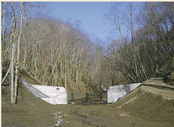
流木捕捉式治山ダムの設置時及び豪雨後の様子
