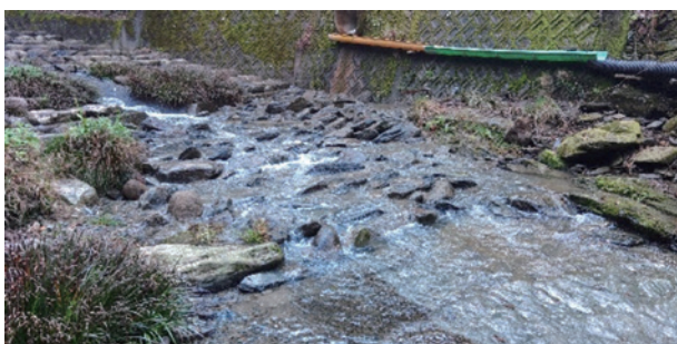
写真2 長崎県多比良川での石組み斜路
