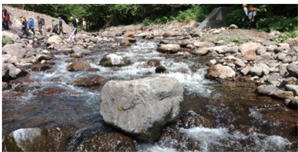
写真1 北海道イワウベツ川での石組み斜路
