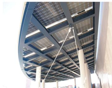
図 2-17 建物一体型太陽光発電システム例
