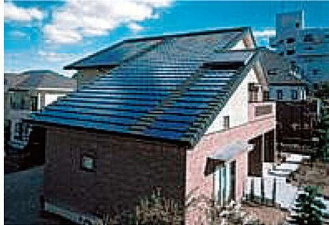
図 2-15 屋根置き型太陽光発電システム例
