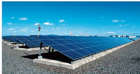
図 2-16 平置き型太陽光発電システム例
