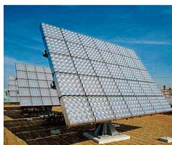
図 2-12 集光型太陽光発電システム
