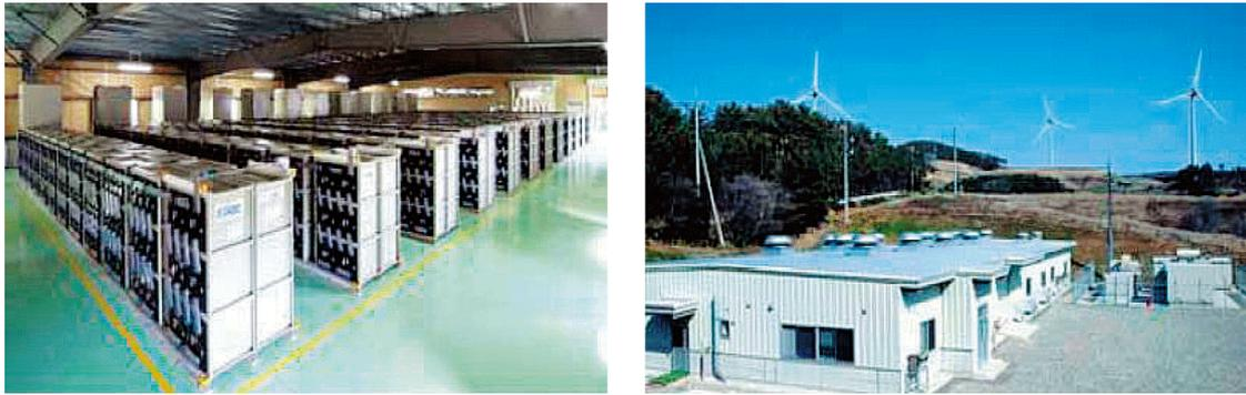
図 9-25 市浦風力発電所における鉛蓄電池バッテリー（10.4MWh）
