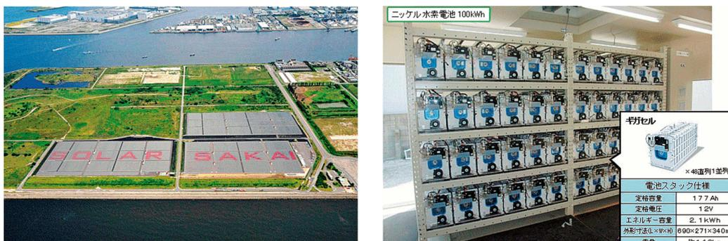
図 9-29 関西電カメガソーラー「堺太陽光発電所」および連系する川崎重工業 100kWh ニッケル水素電池モジュール
