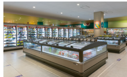
スーパーマーケット・冷凍冷蔵ショーケース
