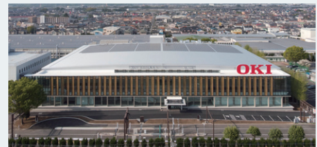
OKI本庄工場H1棟
