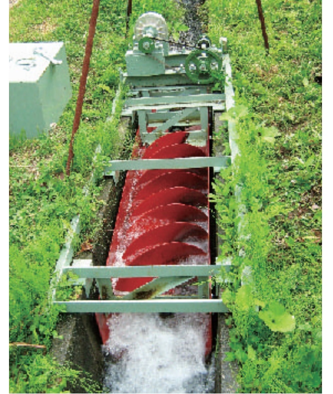
図4 マイクロ水力発電の試作機 農業用水路に設置したらせん水車による発電機。らせん水車は大正時代に富山平野で農業機械用動力として広く普及していた。これを発電機としてリバイバルする研究をすすめている。
