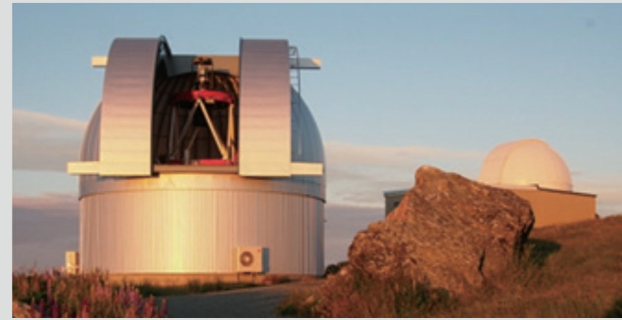
図1 観測に使用した望遠鏡 ニュージーランド・マウントジョン天文台の1.8m望遠鏡(左、MOA共同研究)と61cm望遠鏡(右)。通常は、重力マイクロレンズ効果を利用した太陽系外惑星の探索などに利用されている。
