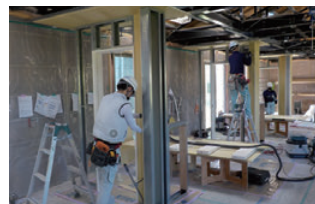
内装施工コース 修了試験風景
