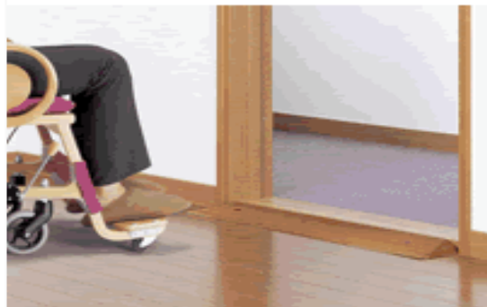
④滑りにくい床材に取替え 階段の滑り止め加工
