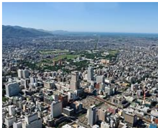
札幌駅北口地区 地域冷暖房施設
