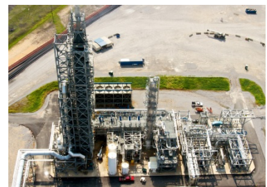
CO2回収プラント(米国)
