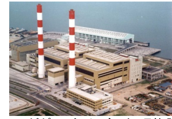
シンガポール向け ゴミ処理施設
