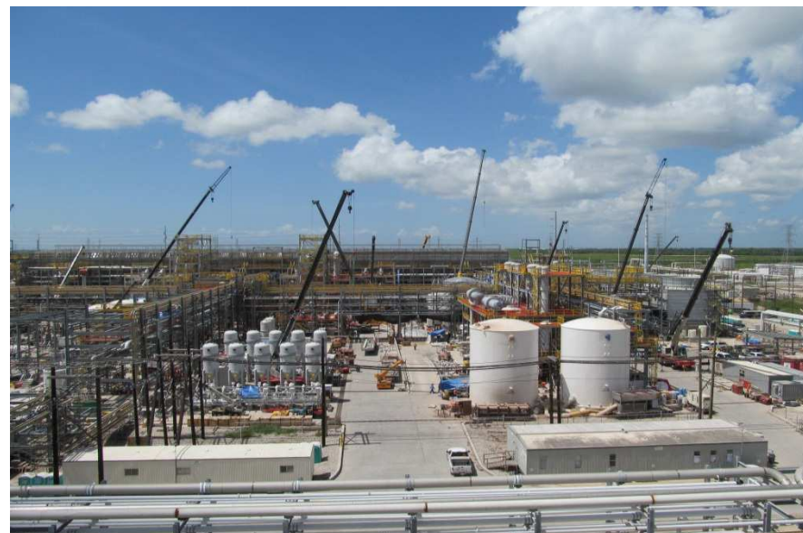
電解工場の建設現場
