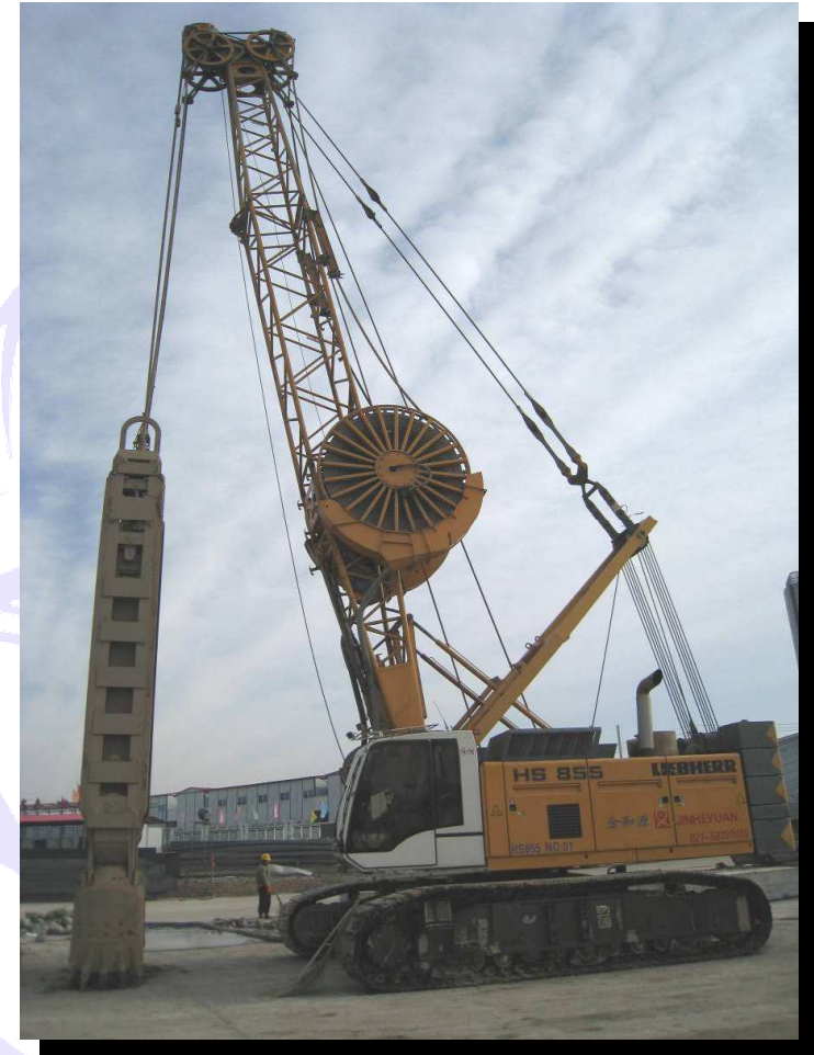
武漢地下鉄現場
