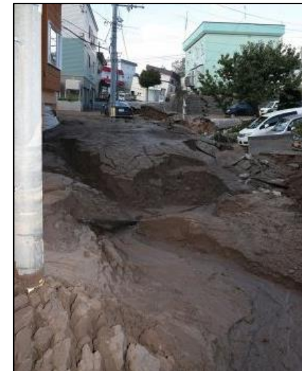
「液状化と見られる現象で陥没した道路」 北海道新聞どうしん電子版 2018/09/07 02:57より
