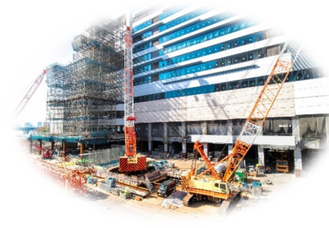
外壁工事・内装工事等
